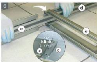
Фаза 6. Соединить траверсу с рельсом [e] с верхушкой пенала и задвинуть до щелчки [щелчка].
