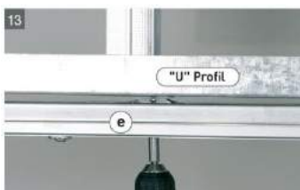
Фаза 13. Закрепить траверсу с рельсом [e] к элементам проема используя саморезы. Внимание: к верхнему профилю [U] пенал закрепить снизу через отверстия в рельсе, чтобы была возможность демонтировать рельс в случае надобности.
