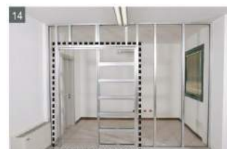
Фаза 14. Закрепить вертикальные стойки [f] и [c] к металлическому каркасу проема (с маленькой буквы саморезы в комплект не входят). Внимание: листы гипсокартона крепить к пеналу исключительно на саморезы 3,5x19 (в комплекте). Если крепить другими саморезами, то ECLISSE снимает с себя всякую ответственность, в случае порчи полотна.
