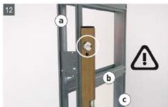
Фаза 12. Для обеспечения правильного движения полотна, пенал должен быть установлен по уровню и отвесу.
