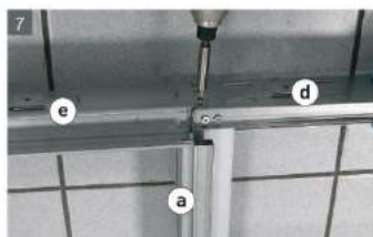
Фаза 7. Закрепить траверсу с рельсом [e] и верхний профиль пенала [d] саморезами 4,2x9,5мм из упаковки [m].
