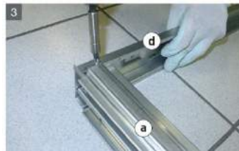
Фаза 3. Закрепить верхний профиль пенала [d] к вертикальным стойкам [a] и [c], используя саморезы 4,2x9,5мм из упаковки [m].
